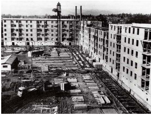
図 2 1963 年フランス PCa 住宅施工現場 図 3 1960 年代末 PCa 構法 [3] 図 4 フィンランド BES 工業化標準システム [1]
