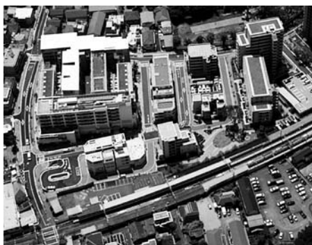
芦花公園駅南口地区市街地再開発事業 東京都世田谷区南烏山 UR都市機構施行 2008年5月竣工 地区面積 1.96ha 実現容積率 210%
