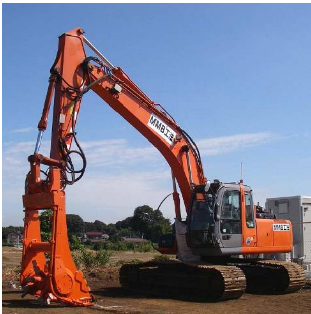
地盤改良機全景
