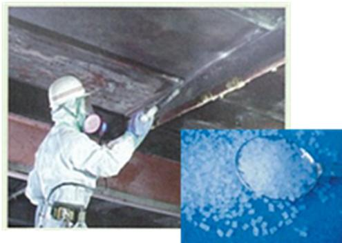
ドライアイスブラスト: ドライアイスペレット(個体)を高圧で噴射し、「個体から気体へ昇華する」際に付着している石綿を除去します。条件により細部や狭隙部の石綿を除去が可能で、除去後に気化する為廃棄物の処理が低減されます。
