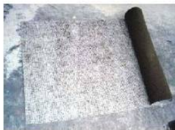
ビニロン繊維面 タイル下地面
