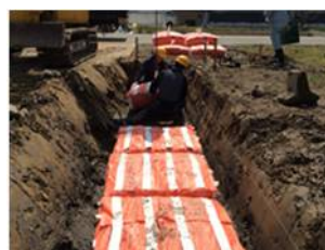
写真4 線状連続敷設
