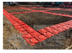
写真6 設置完了状況 (LS100の上にSS45を設置)
