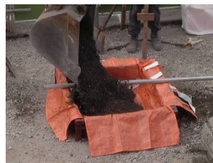
写真2 中詰め材の投入
