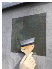
写真2 増粘型浸透性防錆剤の塗布状況
