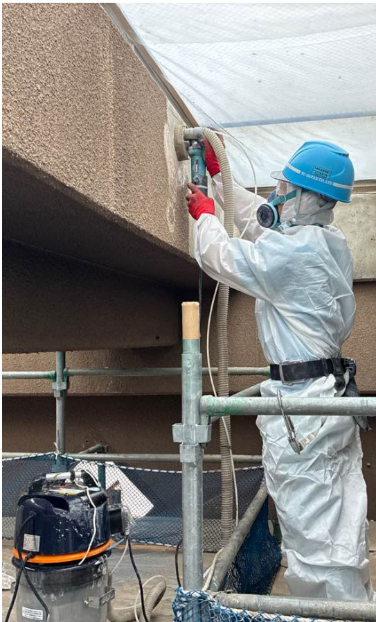
【TC-WT工法 施工状況】
