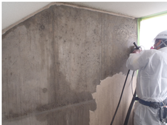
除去作業状況
