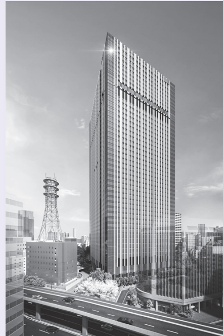
赤坂トラストタワー (提供:森トラスト株式会社 / ©MORI TRUST CO., LTD.)
