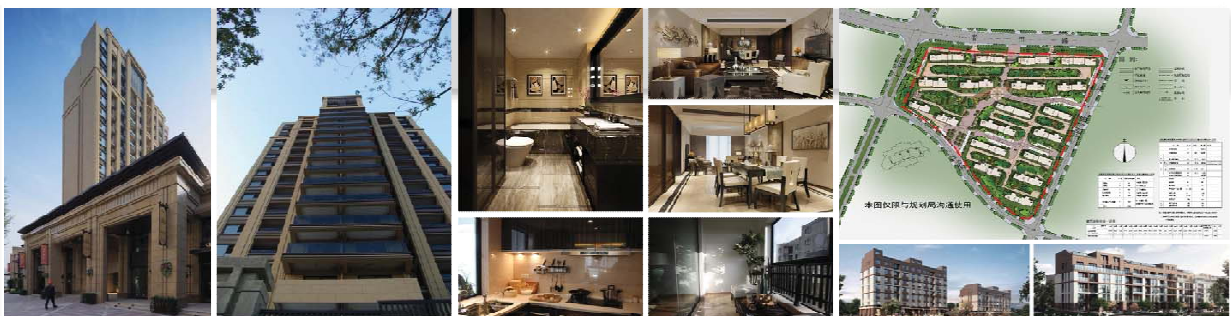
上海緑地威廉公館PJはほぼ完成
