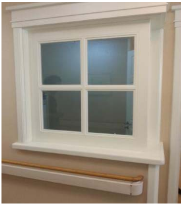
入口に看護人が高齢者の様子を チェックできる窓を設置
