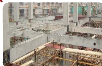
南京上坊保障性住宅
