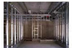
軽量間仕切り
