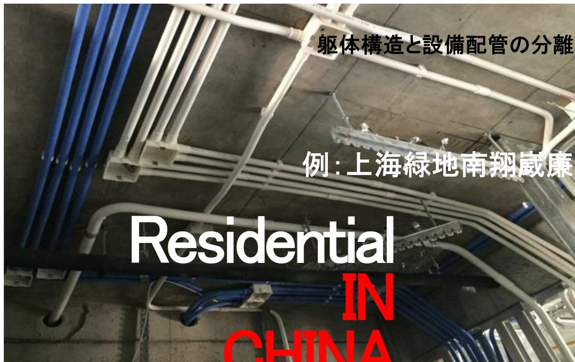
躯体構造と設備配管の分離
