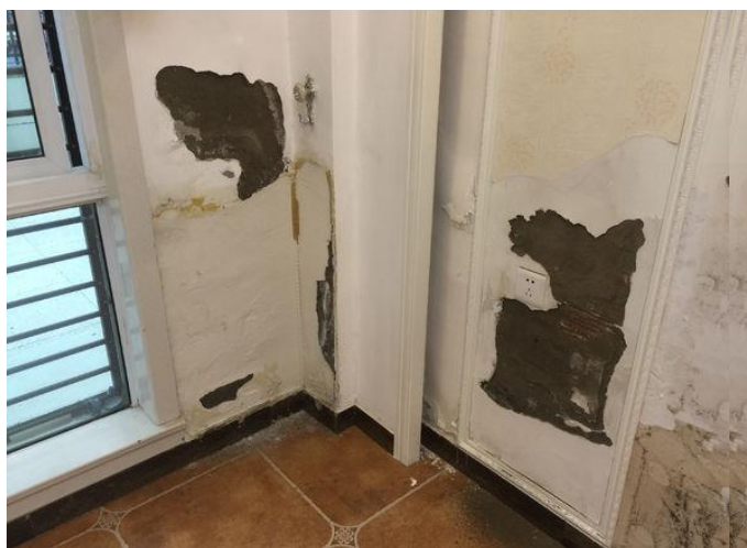
ラテックス塗装面の剥がれ
