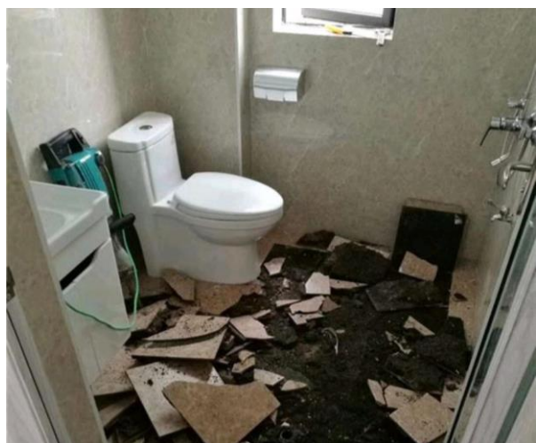
タイル施工の空洞と脱落
