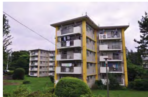
東京都松戸市公営住宅団地
