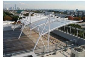
図 1 トラス構造
