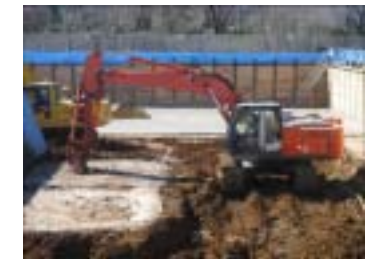
写真 - 5 地盤改良状況
