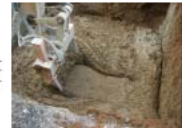
図 - 6 地盤改良状況
